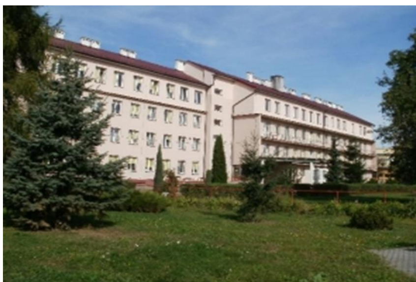
Fotografia 6. Budynek Zakładu Opiekuńczo-Leczniczego w Przemyśle
