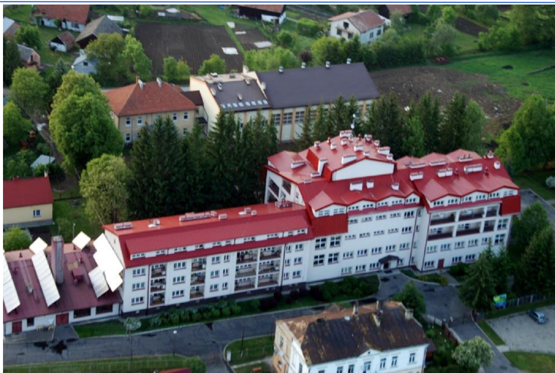
Fotografia 7. DPS Huwniki po modernizacji. Zdjęcie wykonane z drona
