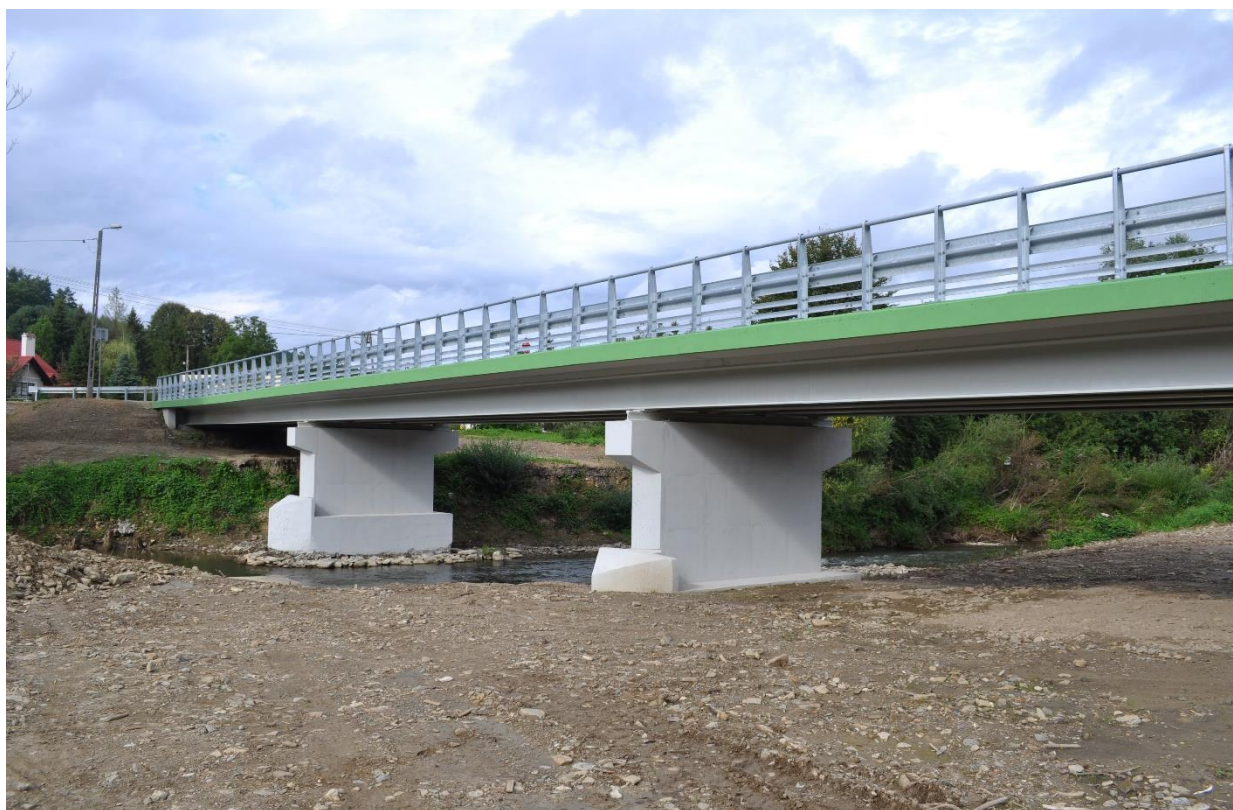
Fotografia 7. Wyremontowany most w Sufczynie (Gmina Bircza)
