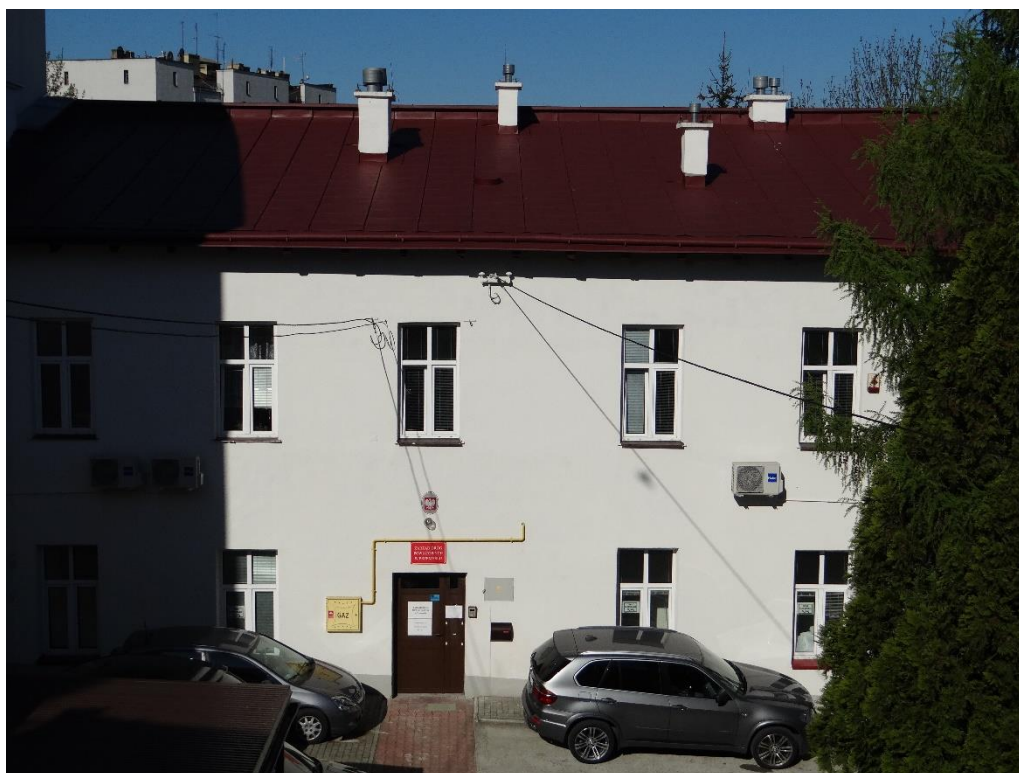
Fotografia 4. Przebudowa budynku administracyjno-biurowego „Oficyny”
