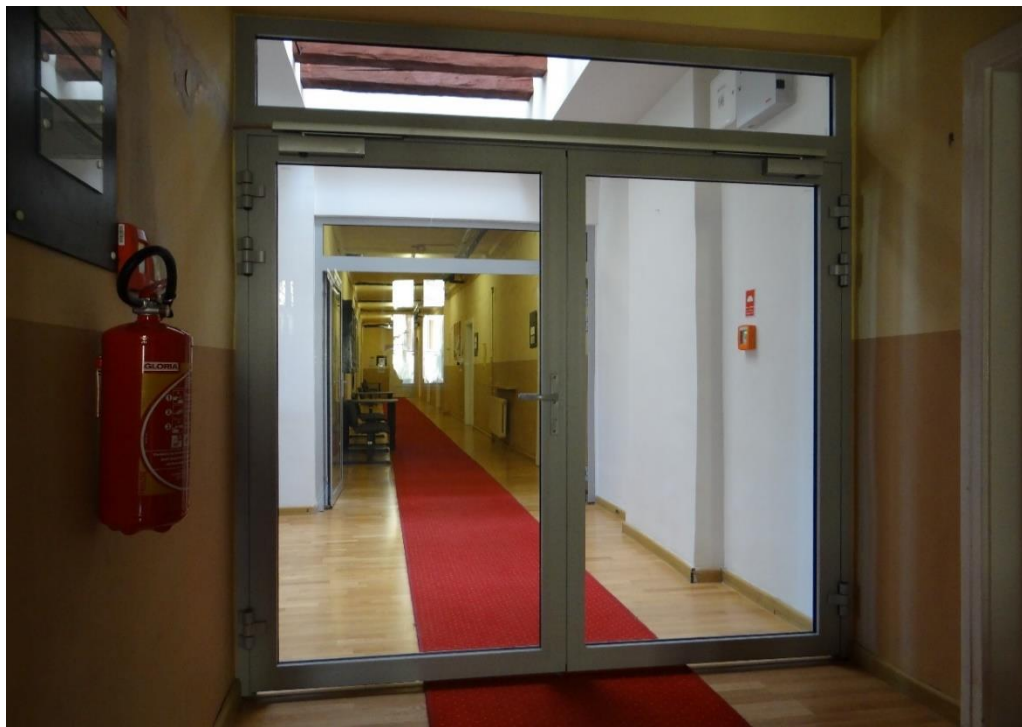
Fotografia 2. Widok fragmentu klatki schodowej przystosowanej do wymogów ochrony przeciwpożarowej (oddymianie).
